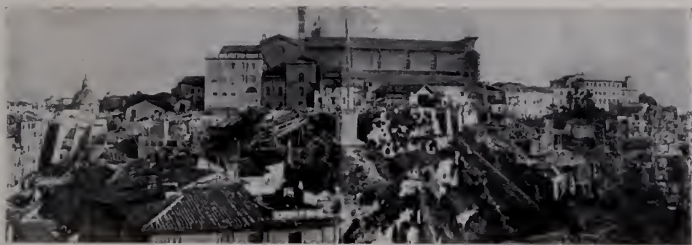
69. — Lato Nord del Colle Capitolino al principio dei lavori
